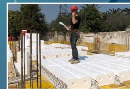
Sicurezza al calpestio durante le fasi di lavorazione
