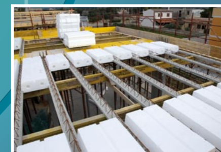
Vista del solaio STEP® in fase di montaggio
