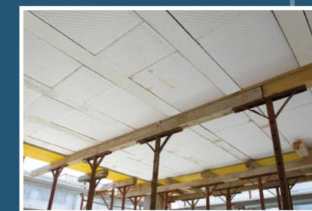
Intradosso del solaio a travetti coibentati
